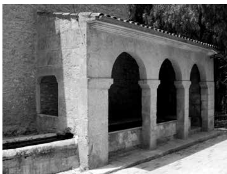
FOTOS 23-27. Carrer de la Font i font de Randa. La font de Randa és un qanawat —una construcció hidràulica àrab— que, després d'alimentar un abeurador i uns rentadors públics coberts per una porxada, aboca les aigües en una sèquia que arribava fins a Lluçmajor.
