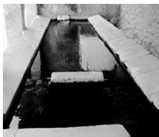
FOTOS 23-27. Carrer de la Font i font de Randa. La font de Randa és un qanawat —una construcció hidràulica àrab— que, després d'alimentar un abeurador i uns rentadors públics coberts per una porxada, aboca les aigües en una sèquia que arribava fins a Lluçmajor.
